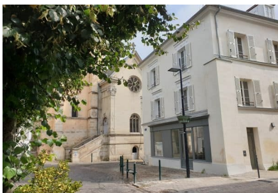
Opération en acquisition-amélioration à Brunoy
