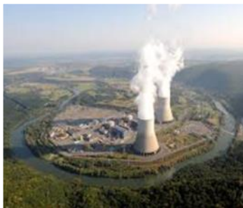
Rejets des installations
