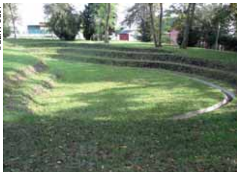
Bassin de régulation des eaux pluviales dans un parc urbain
