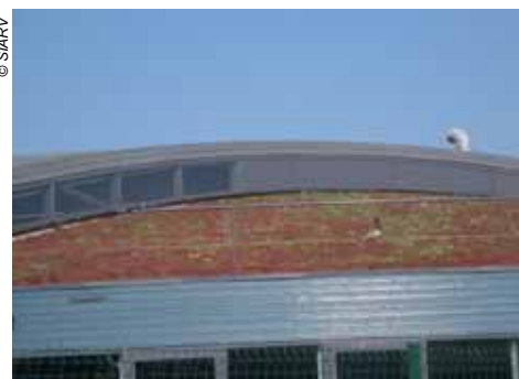
Toiture végétalisée sur un complexe sportif
