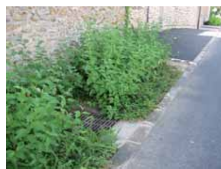
Puits d'infiltration le long d'une rue
