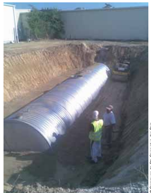
Installation d'une citerne de récupération d'eau de pluie d'un centre technique municipal
