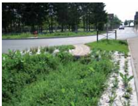
Bassin d'infiltration en entrée de bourg
