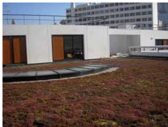
Toiture végétalisée d'un collège
