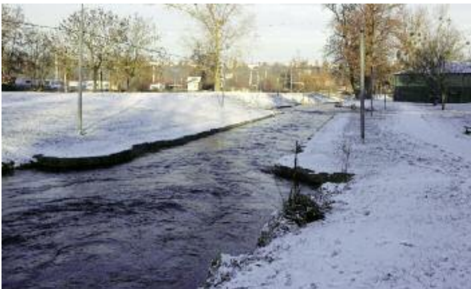
Ancienne écluse du projet du canal de l'Essonne, Corbeil-Essonnes (2009). © Yves Morelle.
