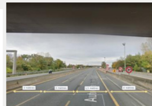
Exemple de création d'une voie supplémentaire dans le cadre du chantier du Tram T12 sur l'autoroute A6 (au niveau du Pont RD31, Ris-Orangis)
