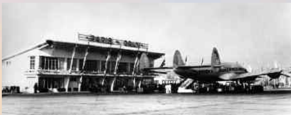
Aéroport d'Orly, 1946. Photographie. 50Fi/7
