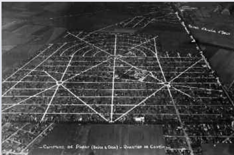
Paray-Vieille-Poste 1950. Vue aérienne oblique. 9S/162
