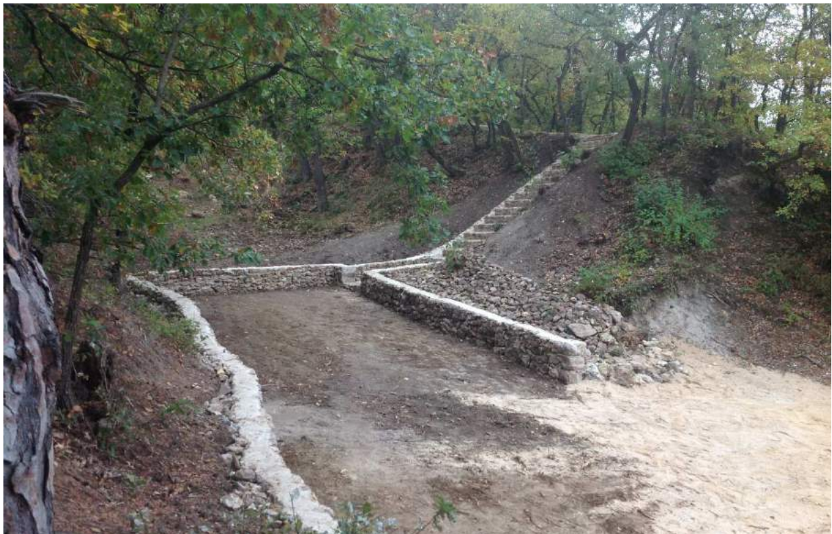
Restauration de murets et d'un escalier en pierres calcaires au Coteau des Verts-Galants – Chauffour-lès-Etrechy
