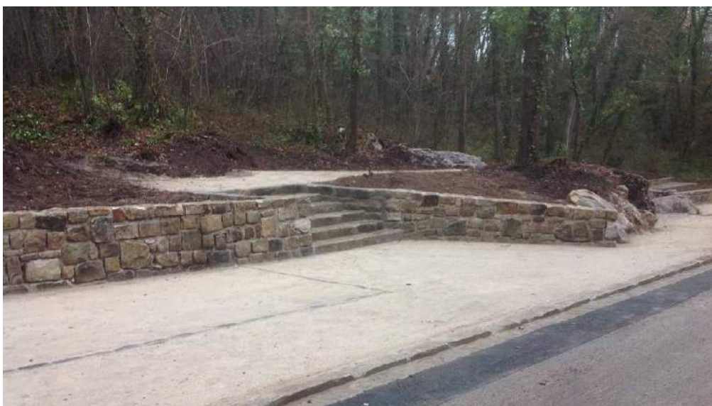
Aménagement d'un parking et d'une zone d'accueil pour le public – Villeneuve-sur-Auvers (décembre 2018)
