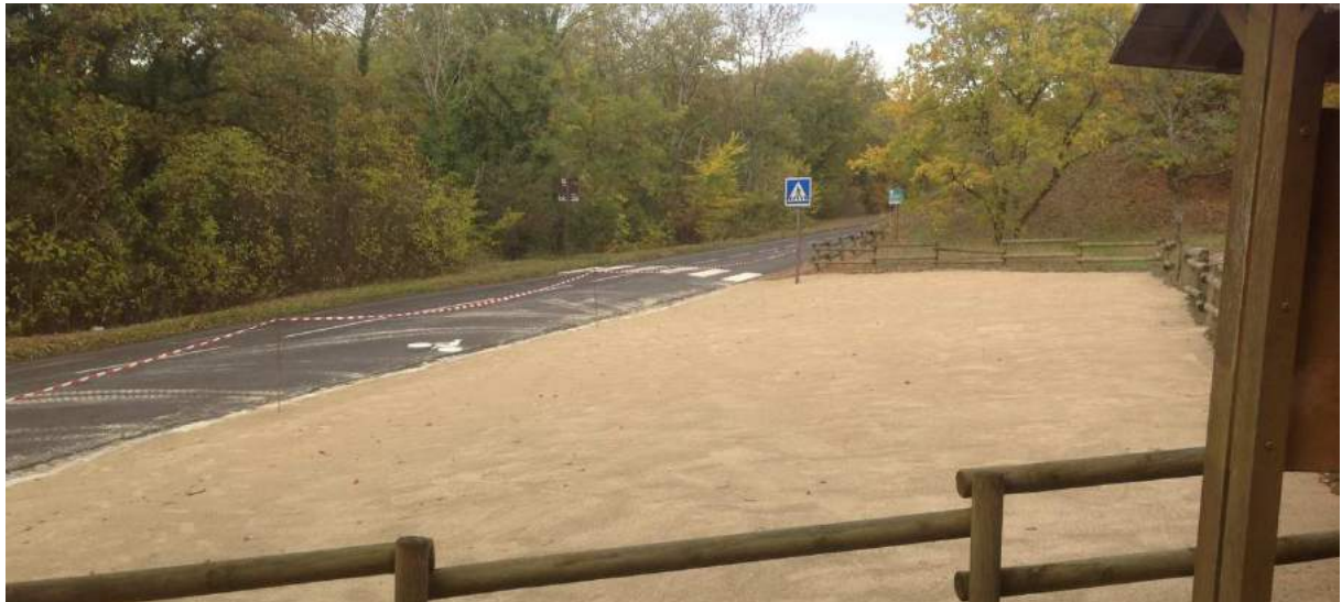
Réhabilitation du parking au Coteau des Verts-Galants – Chauffour-lès-Etrechy (novembre 2018)
