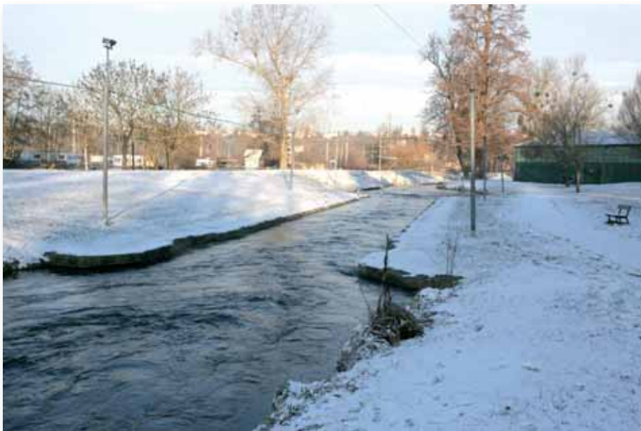
◀ Ancienne écluse du canal de l'Essonne sur le parcours de canoë-kayak de Robinson à Corbeil-Essonnes (2009). © Yves Morelle
