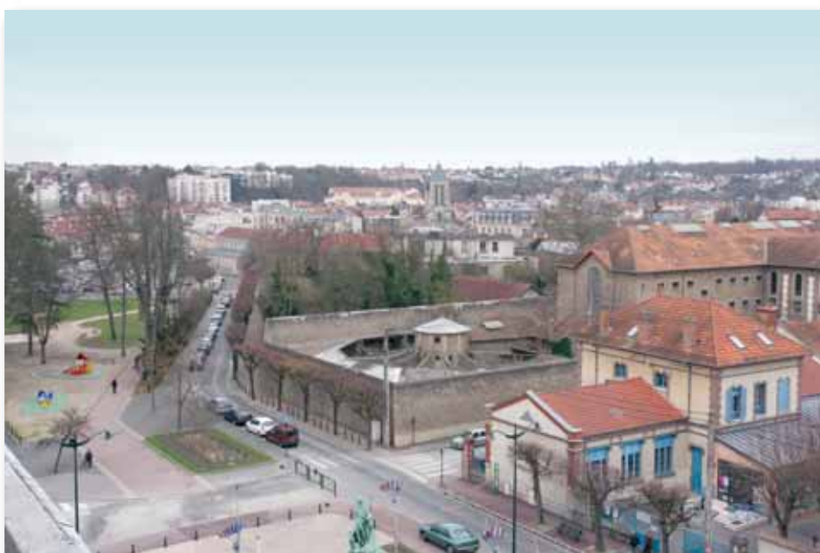
◀ Allées Aristide Briand aménagées sur l'ancien tracé du canal de l'Essonne à Corbeil-Essonnes. Vue prise du théâtre (2009). © Yves Morelle
