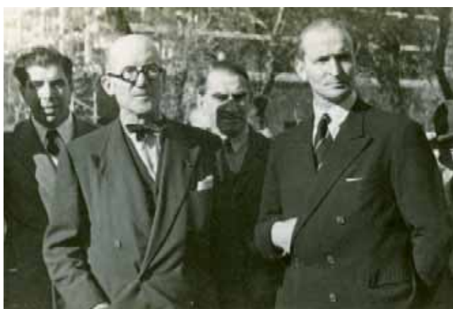
Le Corbusier et Auguste Mione, chantier de la Cité Radieuse de Marseille, 5 décembre 1948. © Photo-Industrielle du Sud-Ouest. © FLC/Adagp, Paris 2008. Collection Scylla Mione-Silvestri.
